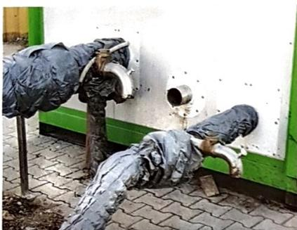
Die Zuleitung (links) und der Rücklauf (rechts) haben Hähne, so dass eine Probenahme einfach möglich ist.
